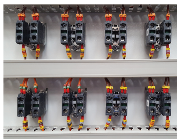
Les fils sont numérotés et repérés
