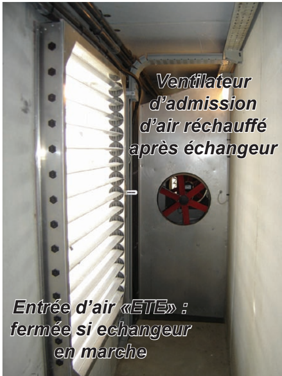
Vue intérieure de la gaine
